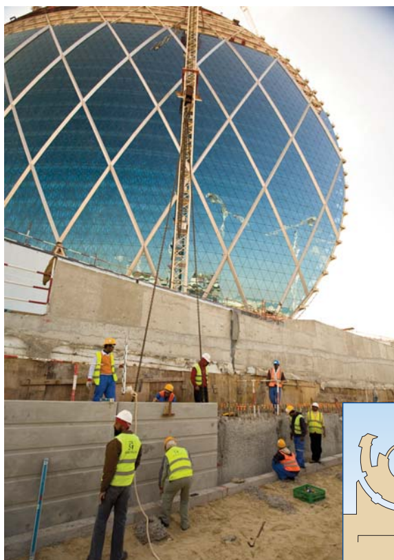
Implementación de paneles prefabricados de revestimiento
