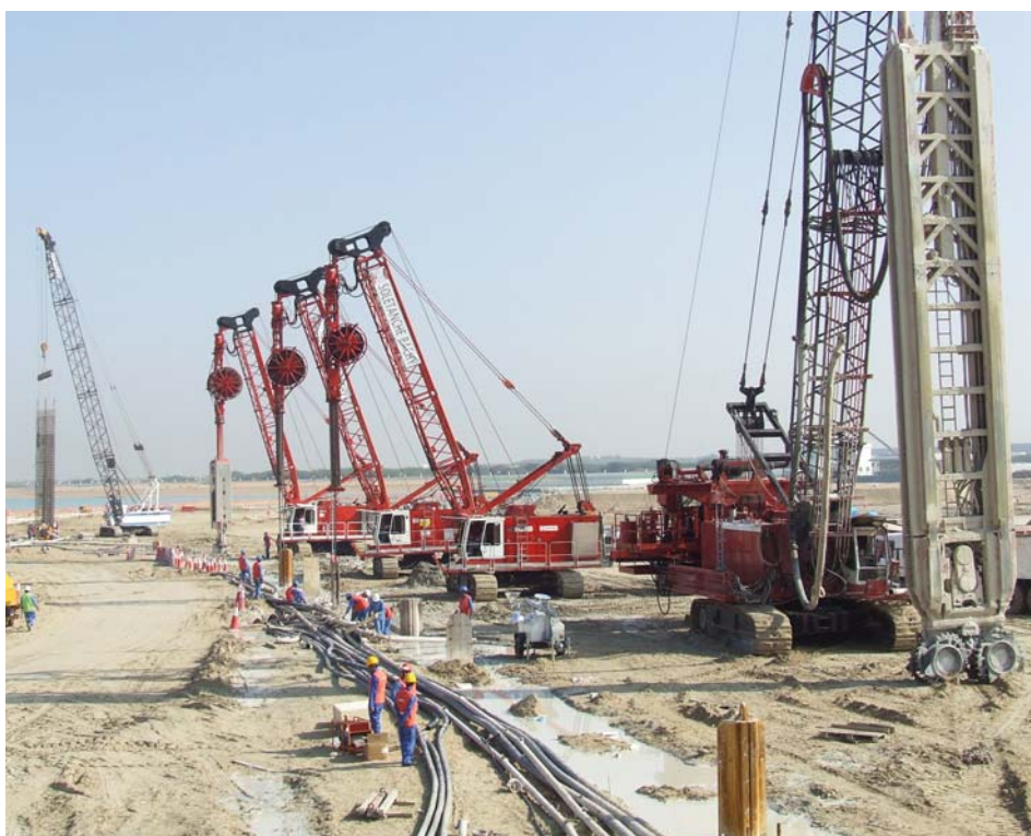
Equipo de excavación a lo largo del futuro muro de muelle de Khor Al Raha (cucharas hidráulicas KS e hidrofresa descansando)
