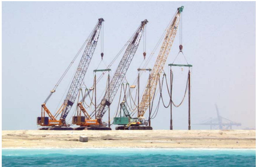
Taller de vibrocompactación tándem en acción. Profundidad de tratamiento de 15 m
