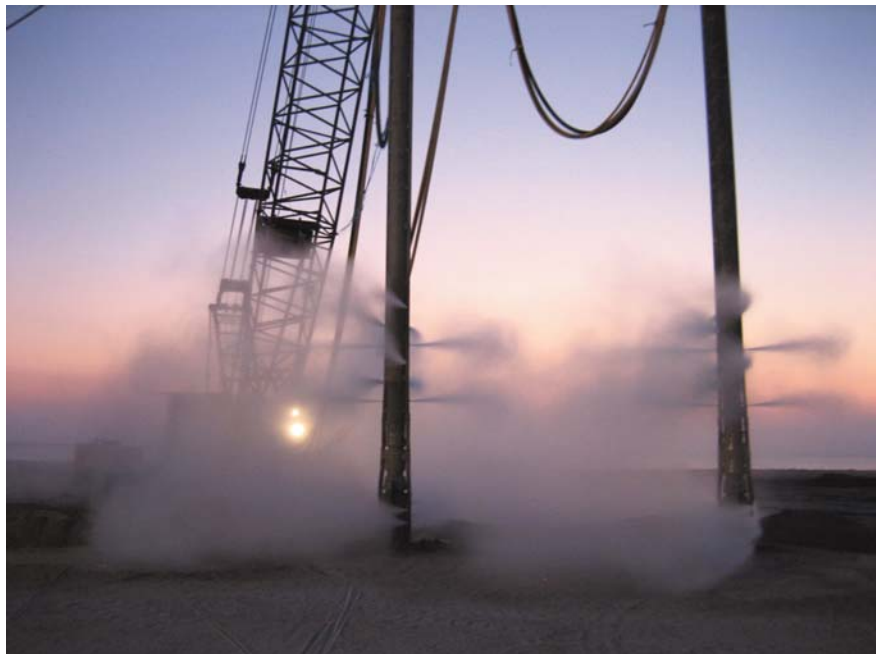
Taller de vibrocompactación tándem en acción. Profundidad de tratamiento de 15 m
