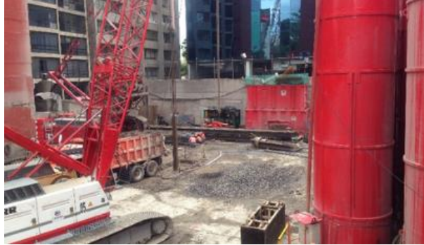
Figura 6. Construcción de barretes
