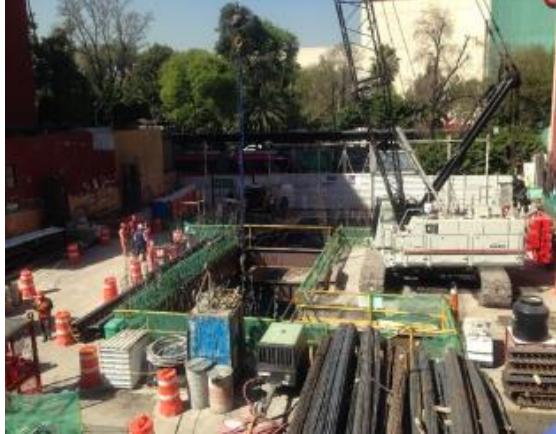
Figure 10. Vista general de la plataforma de trabajo
