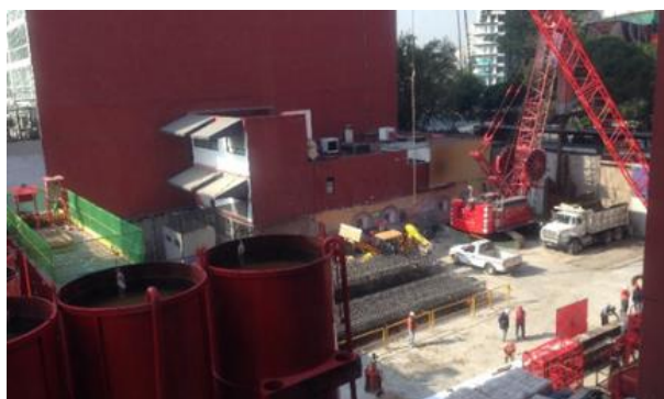
Figura 5. Construcción de sección de muro (panel)
